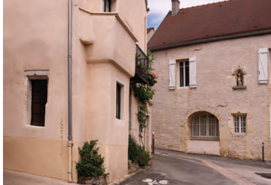
Rue Lebert, des linteaux en accolade ■
