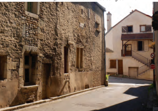
Rue Bernard Mathey, au débouché de la rue du Fg Saint-Martin ■
